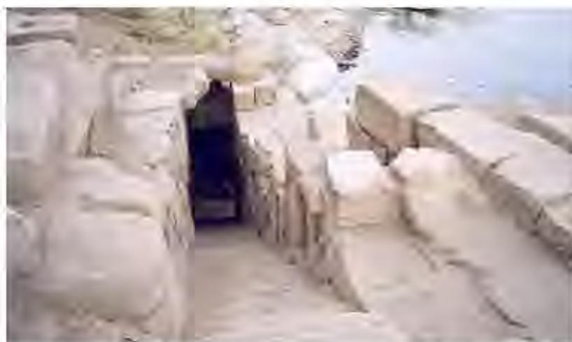
Figura 2.23. Nilómetros para registro de niveles del río (Pascak, a. f.)
